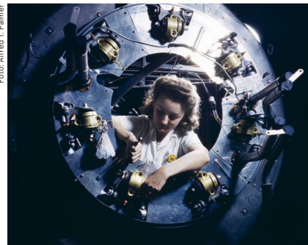
Ein Teil der Verkleidung eines B-25-Bomber-Motors wird in der Motorenabteilung des Werks von North American [Aviation, Inc.] in Inglewood, Kalifornien, zusammengebaut
